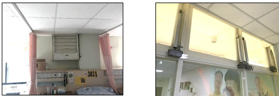
圖 3-55 機械排煙設備（左），自然排煙窗（右），圖左機械排煙設備裝設位置在床鋪之上，是錯誤位置，應遠離住民位置，以免煙流通過住民所在位置。
