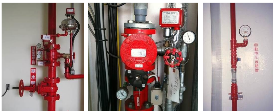
圖 3-43 流水檢知裝置與末端查驗閥
