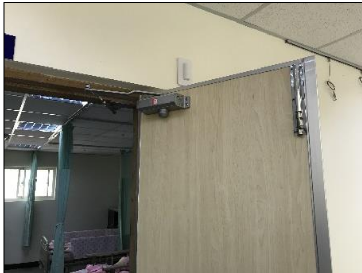
圖 3-2 新竹市某機構所採用的區劃防火門
