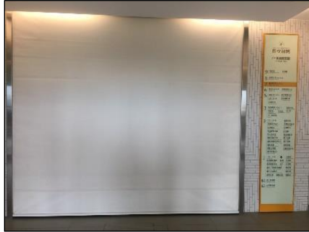
圖 3-1 台中市某護理之家利用遮煙捲簾遮蔽電梯出入口，已達到垂直區劃防煙的效果
