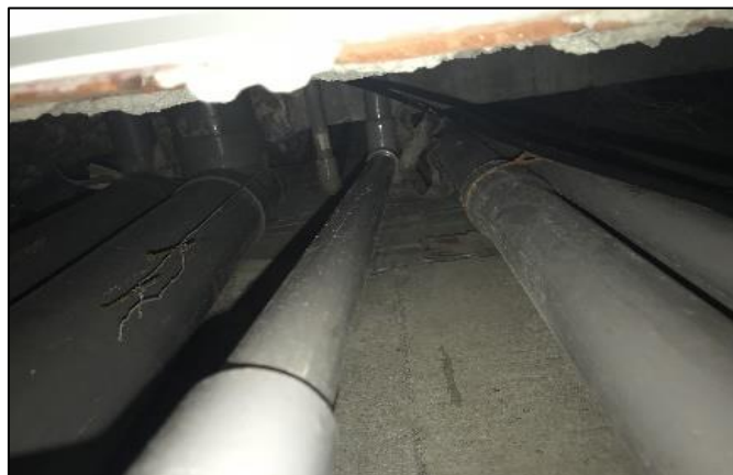
圖 3-3 高雄某護理之家管線貫穿各層，缺乏封閉，可能使樓層區劃被破壞
