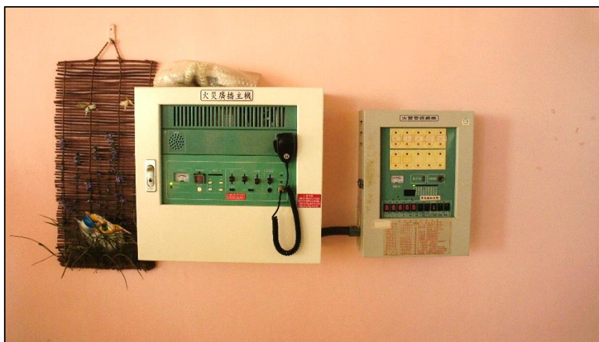
圖 3-45 長照機構常見的受信總機與緊急廣播系統
