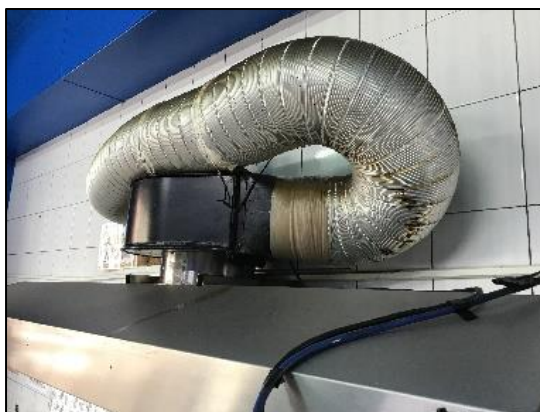
圖 4-6 廚房抽油煙機的風管，可能因常年烹調導致油垢堆積，是潛在的起火點
