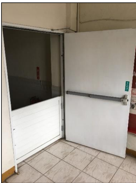
圖 3-15 屏東縣某機構為防止住民隨意進出，於出口處設置磁鎖矮門樓梯
