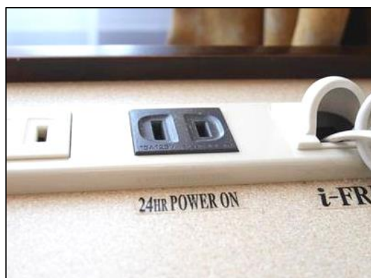
圖 3-58 不斷電插座 （資料來源：翻攝自網路）
