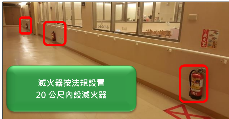
圖 3-27 滅火器步行距離限制示意圖 (資料來源：雙和醫院附設產後護理之家，2016)
