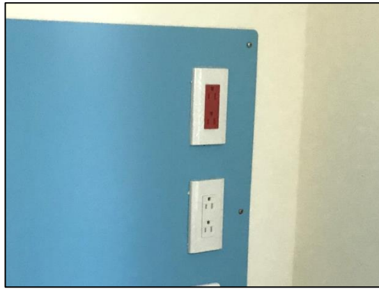
圖 3-57 新竹市某護理之家於每個床鋪之上皆設有緊急電源插座（紅色插座）
